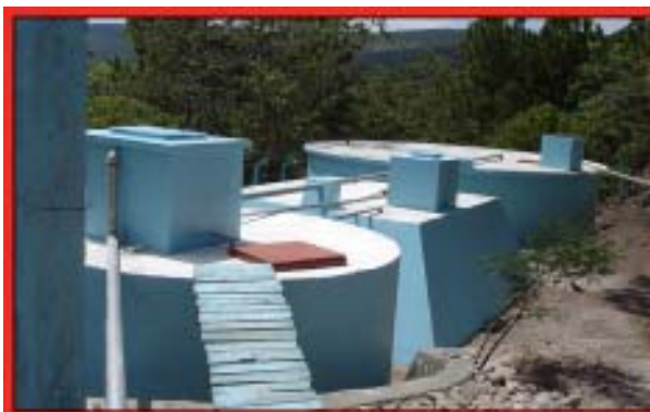
HONDURAS: UNA OBRA DE ENVERGADURA LA CONSTRUCCIÓN DE LA PLANTA DE TRATAMIENTO DE AGUA CON LA CUAL LOS ROTARIOS DE HONDURAS MEJORAN LA CALIDAD DE VIDA A LA COMUNIDAD DE TAMARA.
